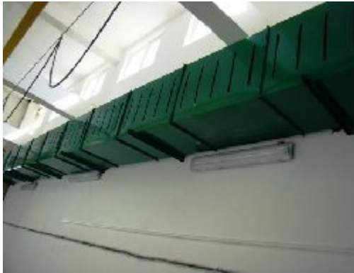
Фиг.2 Въздухопровод/дифузор за равномерно подаване на въздуха през вертикални процеци от схемата на фиг. 1. Дължината на работната част на дифузора L=11 m. Скоростта в центъра на изхода от общо 55-те вертикални процеци е - средно v_0=5,2 m/s като отклонението варира от dv_1=-5,8 % при най близкото до входа на въздуха в устройството до dv_{55}=3\% при най отдалеченото.
