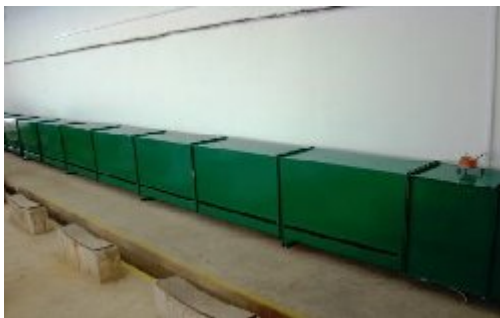
Фиг.3 Въздухопровод/дифузорен тип за равномерно изтегляне на въздуха през хоризонтални процеци от схемата на фиг. 1. Дължината на работната част на канала е L=11 m. Скоростта на въздуха на входа в общо 11 m хоризонтален процеп е - средна v_0=5,6 m/s като отклонението е средно dv=7,8 %
