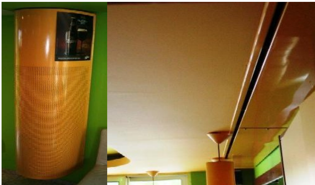
Фиг.5 и Фиг.6 Дифузор с перфорация, за равномерно подаване на въздуха в близост от заетата от хора зона и надлъжен процеп/шилиц на тавана за равномерно изтегляне на въздуха от
